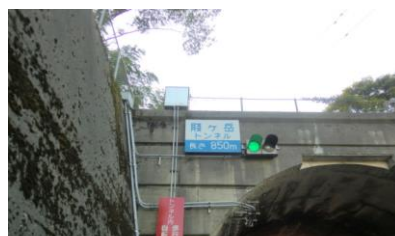
賤ヶ岳トンネル
